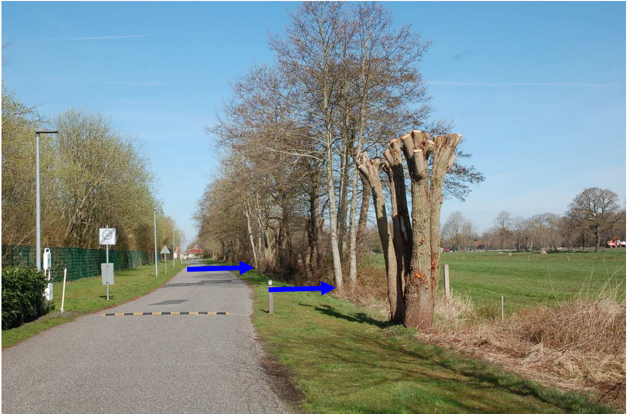
Foto 3: Blick Richtung Nordosten entlang der Straße „Am Mölenland“. Die blauen Pfeile markieren Anfang und Ende des rd. 50 m langen Abschnitts, in dem die Entwässerungsmulde im Straßenseitenbereich angelegt werden soll und die beiden Schwarz-Erlen, die auf der straßenzugewandten Seite des Grabens aufgewachsen sind.
